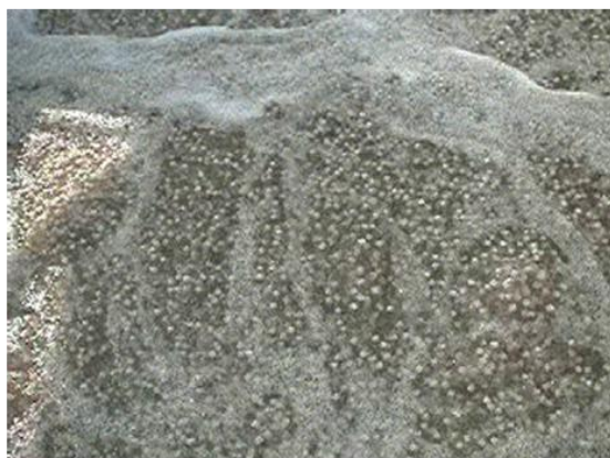
Πληρωτικό υλικό σε αιώρηση μέσα σε δεξ. αερισμού
